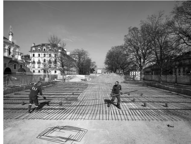
Les travaux du Pavillon de la danse ont commencé en janvier 2019. Un simple radier sur une semelle en béton. Ça n'a l'air de rien, mais il aura fallu 22 ans à l'ADC pour poser le socle du Pavillon.
