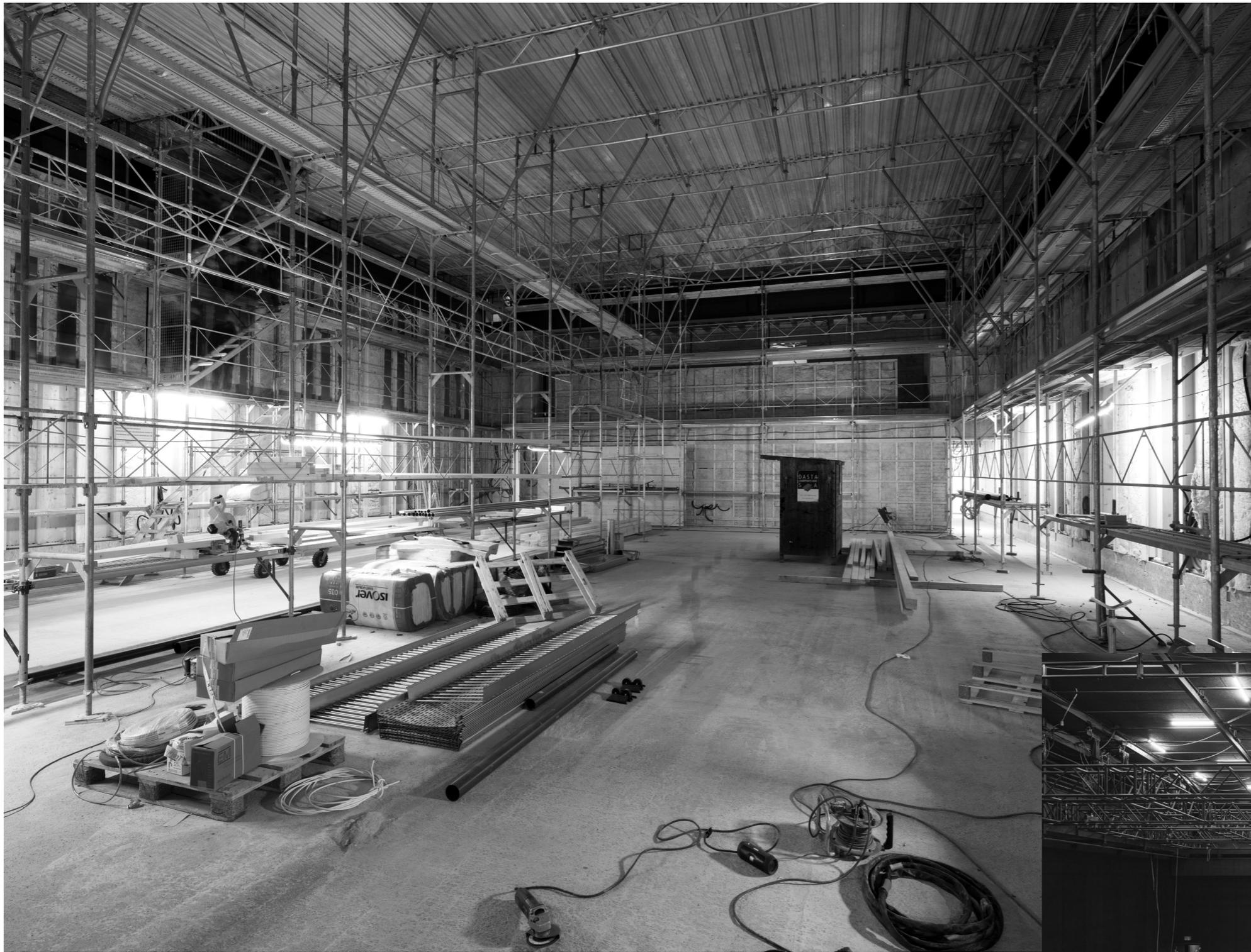
Pour une bonne acoustique, la salle de spectacle est conçue comme une boîte dans la boîte, désolidarisée de la structure primaire. Les panneaux acoustiques perforés servent aussi à la ventilation : l'air est insufflé depuis le toit, récupéré et évacué vers la pompe à chaleur située en dehors du bâtiment. La récupération de l'eau de pluie se fait par 170 petits collecteurs camouflés en façade.
